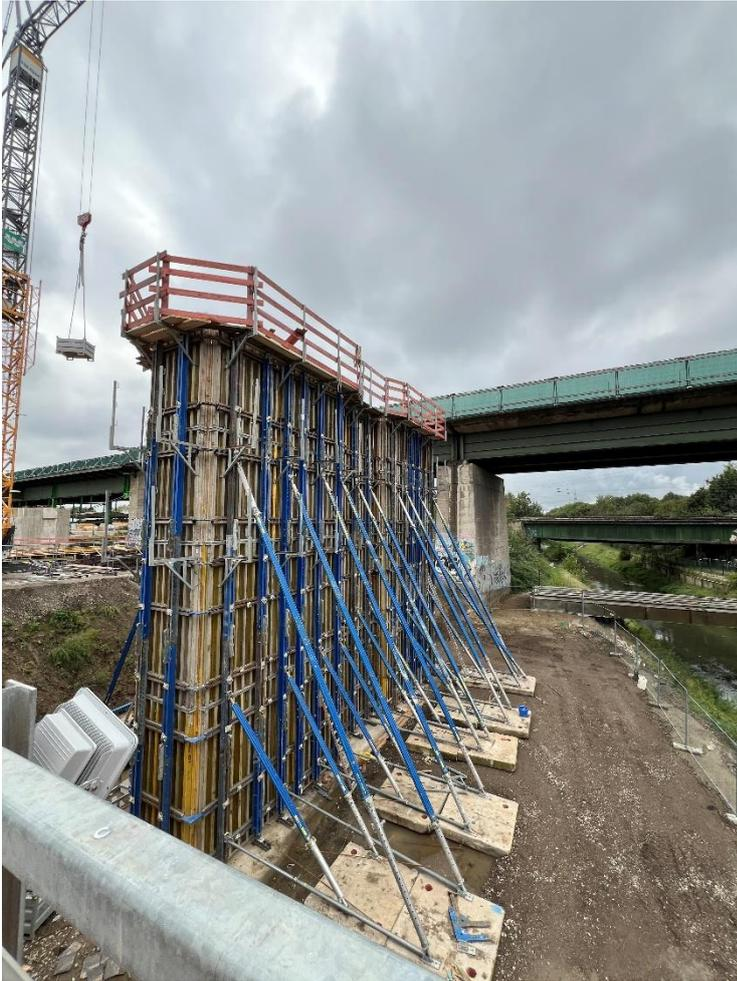
*Bild 13 – Errichtung Widerlager (Brückenunterbau)
