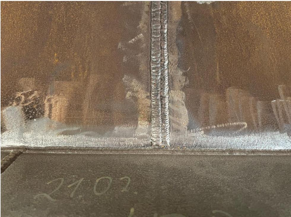
Bild 10 – Brückenvormontage, Schweißnahtstoß
