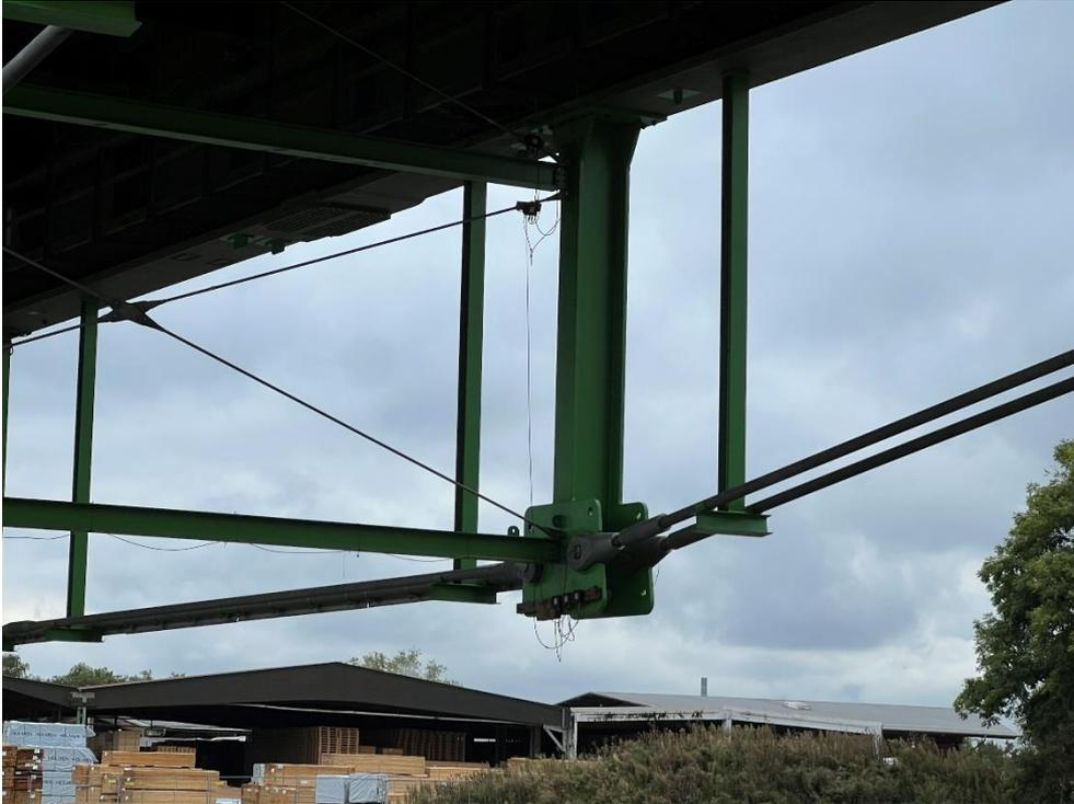
*Bild 14 – Verstärkende Stahlkonstruktion befahrbare Brücke*
