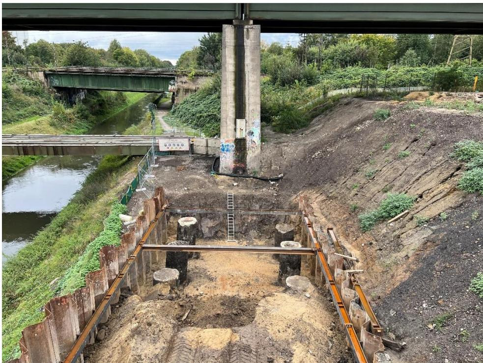
Bild 12 – Errichtung Widerlager (Brückenunterbau)
