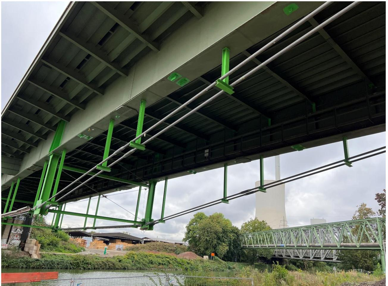
Bild 5 - Verstärkte Brücke über dem Rhein-Herne-Kanal
